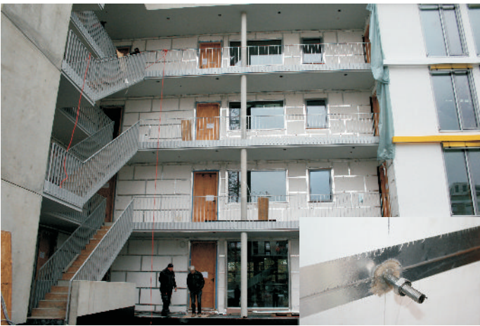
Montierte VT-A-B1 (QASA Firetherm) -Fläche in München, Ackermannbogen (Architekt Werle)
