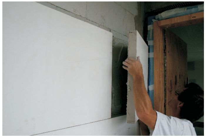
Montage der VT-A-B1 (QASA Firetherm) -Elemente im Klebebett
