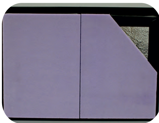
QASA-D-VT-I-B-2 XPS-5 Bodeninnendämmung
