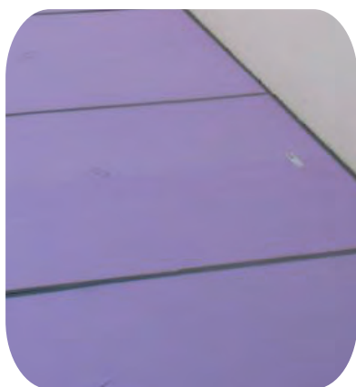
QASA-D-VT-I-B-2 XPS-5 Bodeninnendämmung
