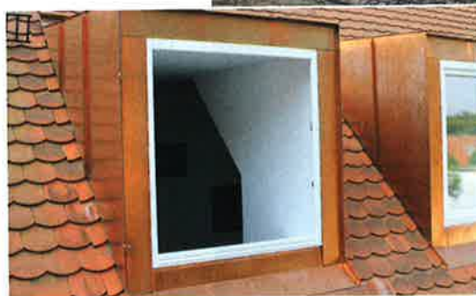
2 Durch den Einbau von Vakuum-Isolationspaneelen von Variotec ist es dem Architekten Wolfgang Knychalla gelungen, für Dach und Seitenwangen gleich breite Ansichten zu konstruieren, die ein Maximum an Lichteinfall ermöglichen.
