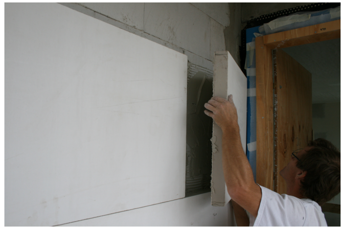
Montage der Elemente im Klebebett
