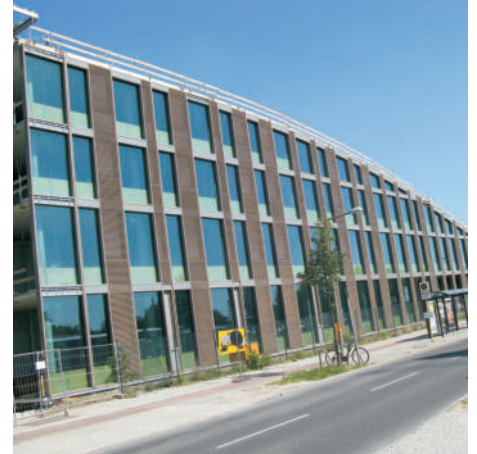
Solon AG Adlershof Architect Schulte-Frohlinde
